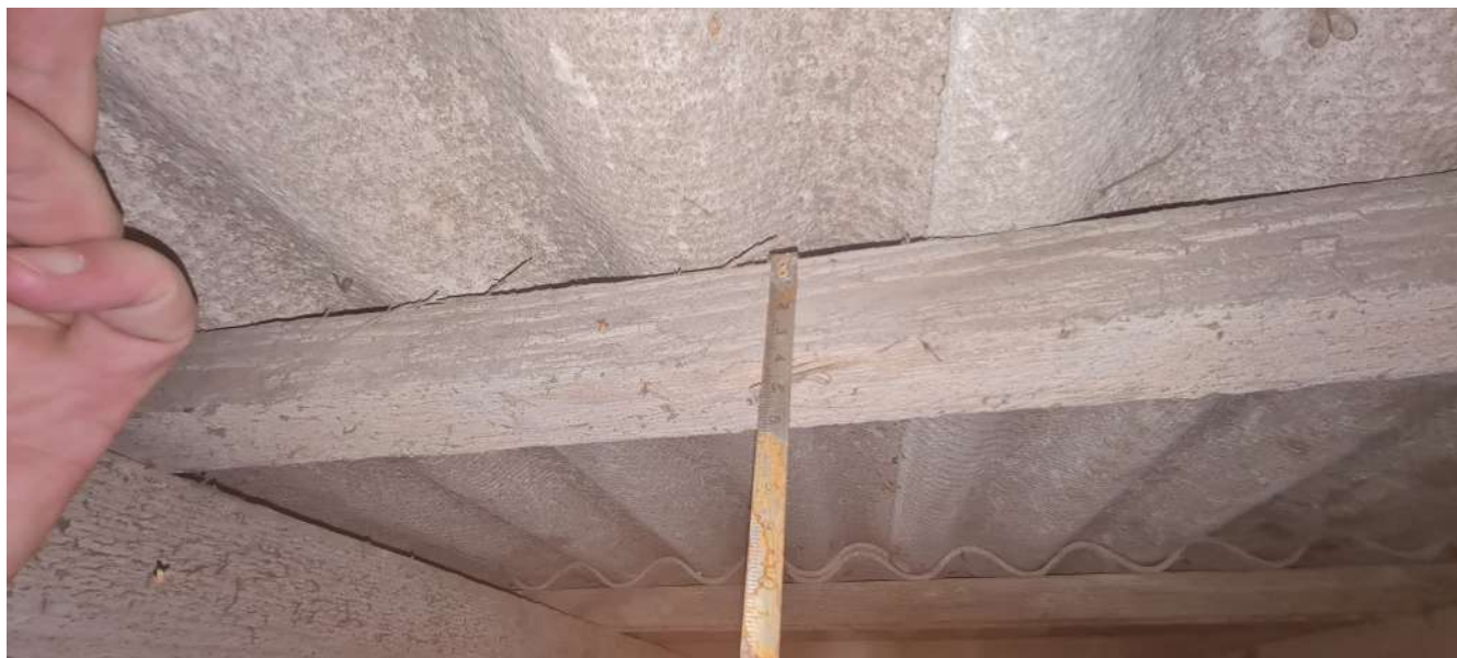
14.att. Zem jumta segums ierīkots latojums 40x40, solis 0.5m; atkarībā no izvēlēta jumta seguma jāpielāgo latojums.
