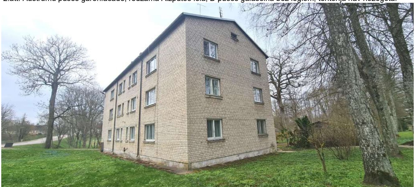
3.att. Zun D puses galasienās izvietoti logi. Ēkā nomainītas ārdurvis un lielākā daļa no logiem (nav nomainīti 9 logi).
