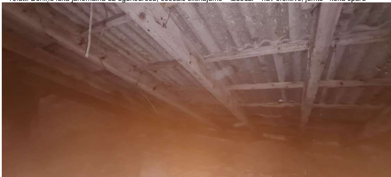
11.att. Jumta nesošā konstrukcija ir koka spāres 60x160mm, solis 900mm; stati un atgāžņi 100x100mm. Azbestcimenta vilkplātņu jumta segums atrodas neapmierinošā tehniskā stāvoklī un jānomaina uz citu videi draudzīgu materiālu. Koka konstrukcijas lokāli satecējušas; pēc vietas jāizskata nomaināmie elementi.
