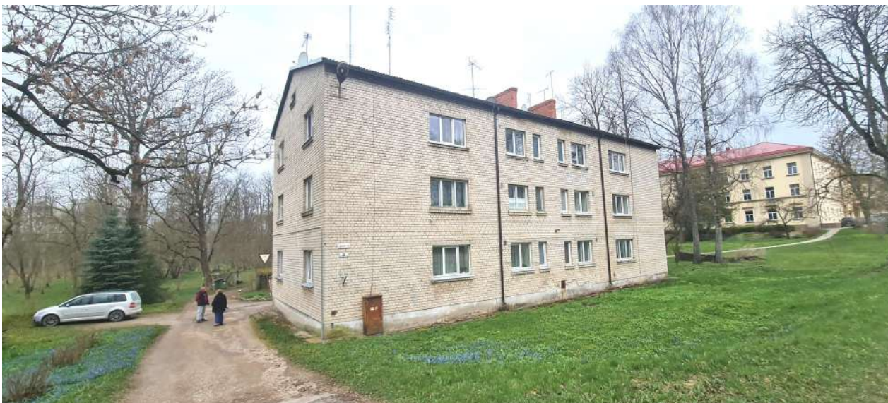
Dzīvojamā ēka Aizputes ielā 3, Priekulē, Dienvidkurzemes novads. DR puses fasāde, 2023.gads.
